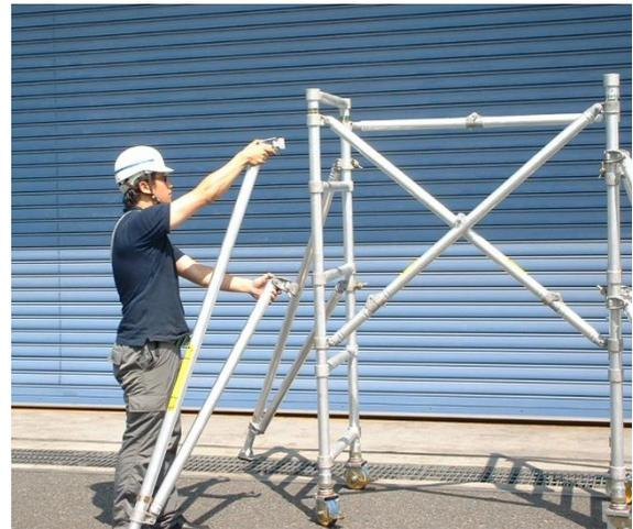
先端にある金色のピンを外して長さの調整をしてください。5段階で調整が可能です。
