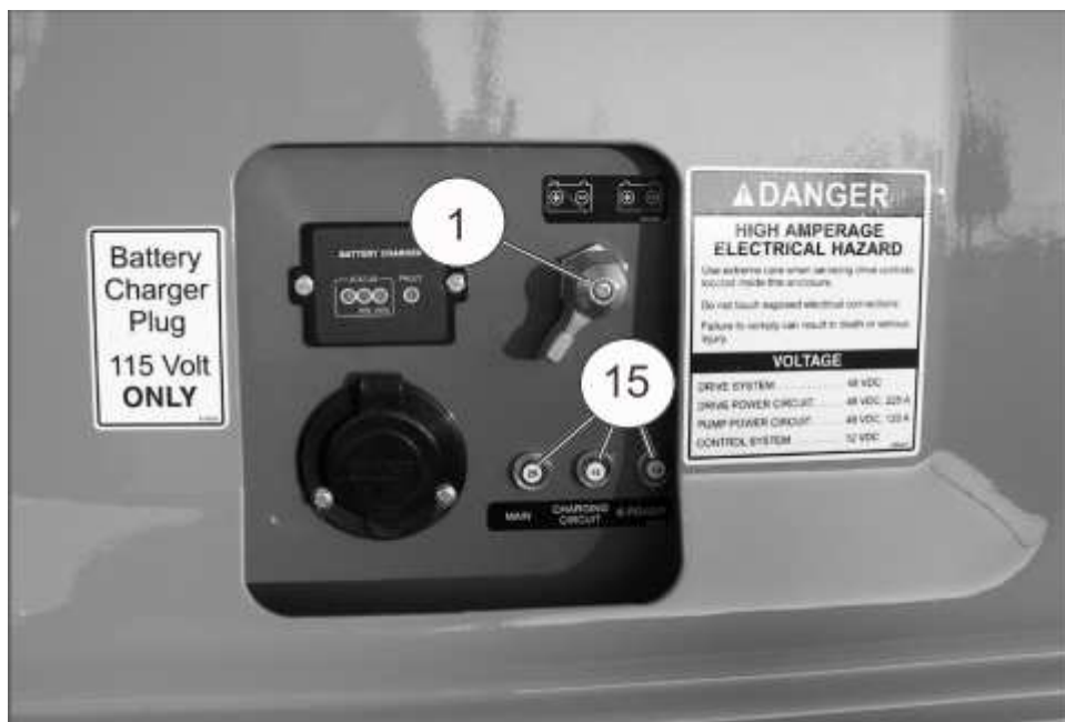
1. バッテリー電源切断スイッチ
