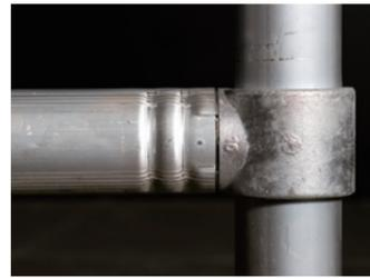
加締による圧着は溶接の数倍の強度を誇ります。
