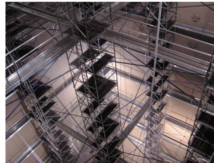
スナップアウトとスパンデッキの組み合わせで、火力発電用ボイラーのメンテナンスシステムを構築することが出来ます。
