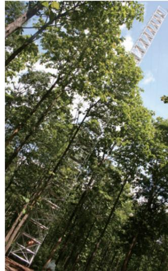
フォレストタワーは気象観測用のタワーです。アンカーによる基礎を作り、ガイドワイヤーを張ることで20-30mの高さのタワーが建てられます。
