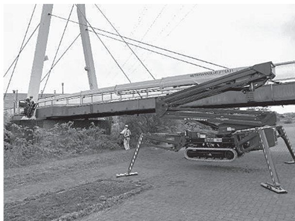
写真6 橋梁点検の様子（型式SA31）
