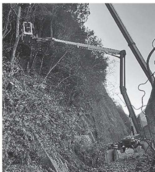
写真5 法面での樹木伐採作業 (型式SA22)
