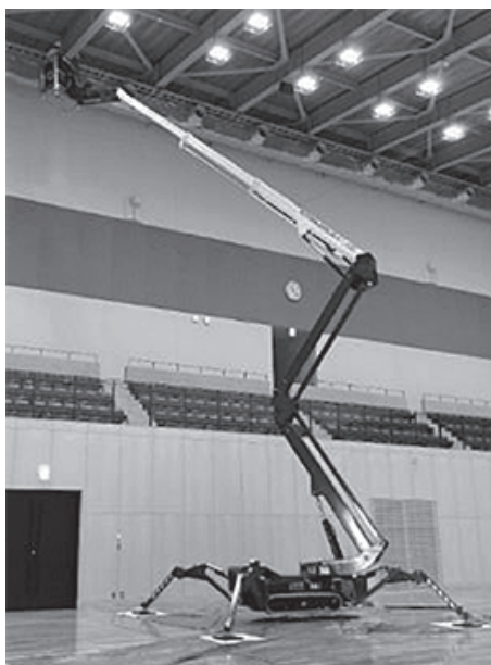
写真7 床面に耐荷重制限のある現場（体育館：型式SA22使用）メンテナンスの様子
